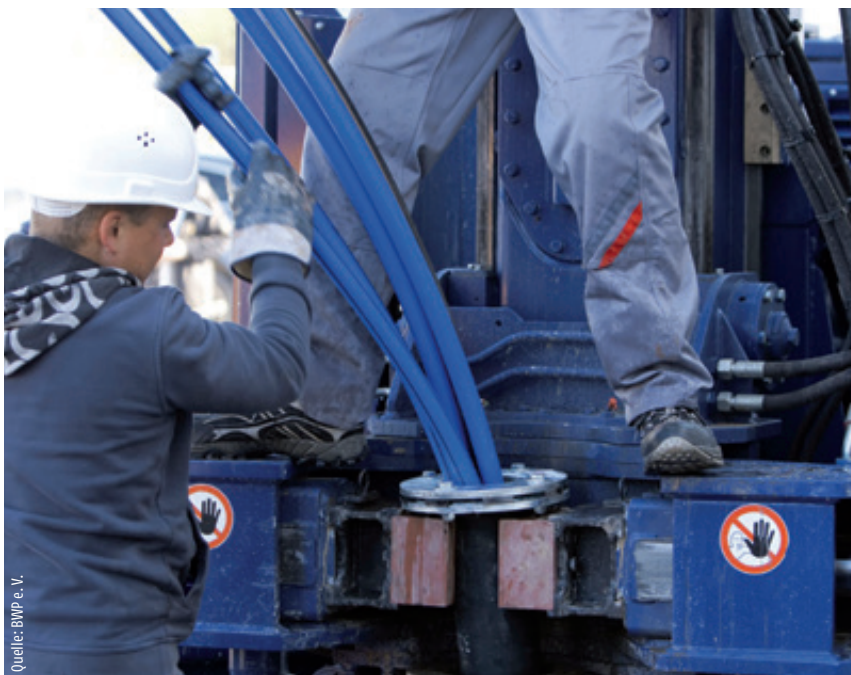
Abb. 3 – Ist die Bohrung erfolgreich abgeschlossen, kann die Sonde ins Bohrloch eingebracht werden.
